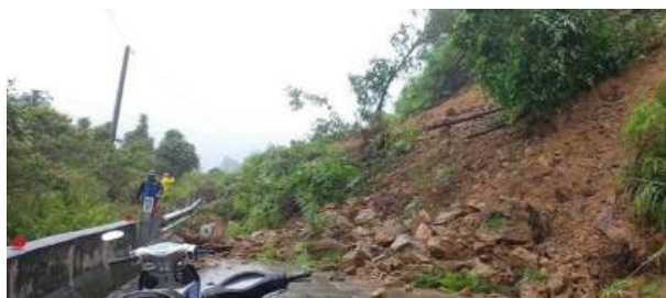
Hình 2.2. Sạt lở đất ở đường Hồ Chí Minh qua địa phận Hương Nguyên (huyện A Lưới) năm 2023
