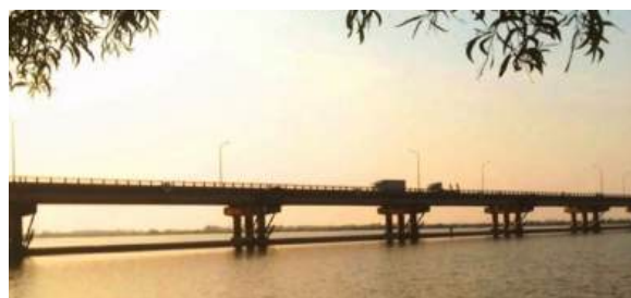
Hình 2.5. Đập ngăn mặn Thảo Long ở xã Hương Phong (thành phố Huế)
